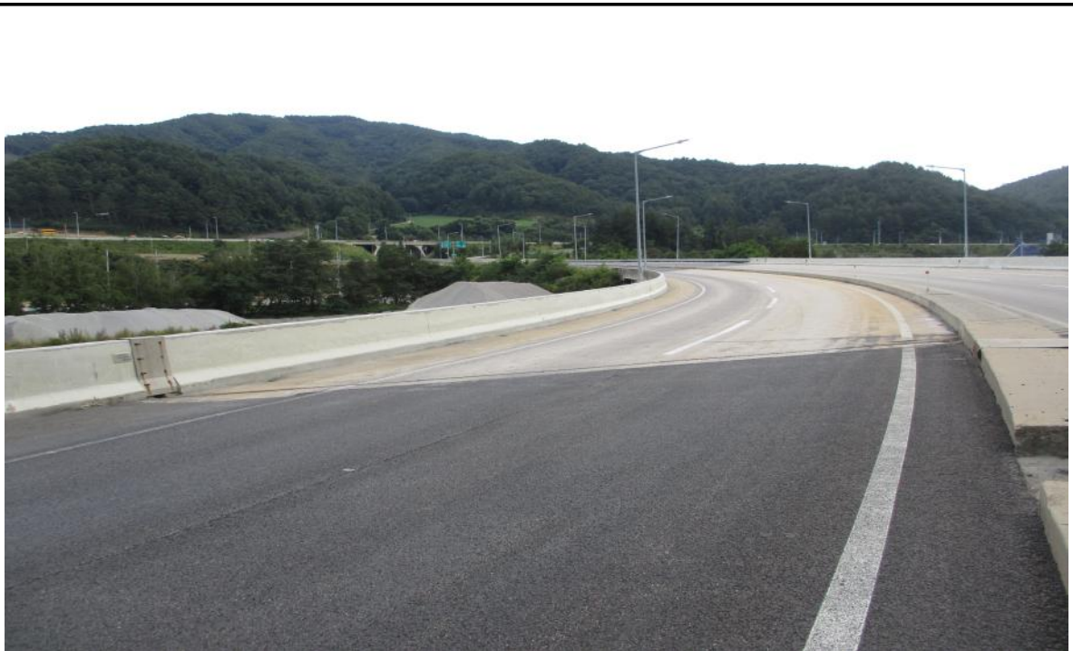
교량 상부 전경
